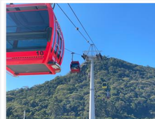
MORRO DA AGUADA ATUALMENTE
