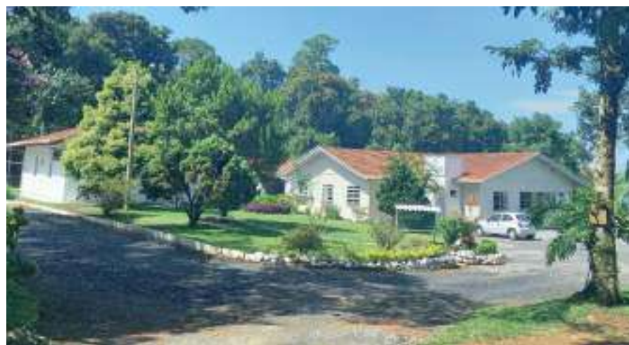
Unidade de Acolhimento em Ituporanga(SC)
