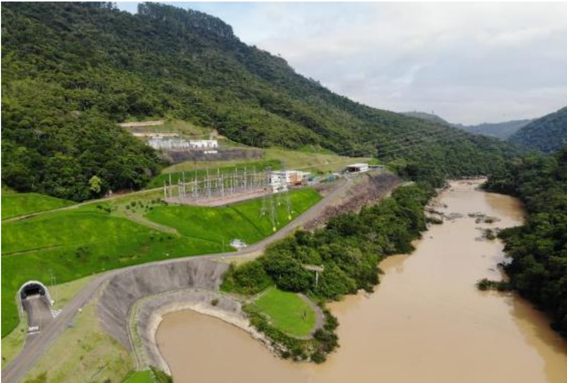
Foto 1 - Vista Panorâmica da UHE Salto Pilão
