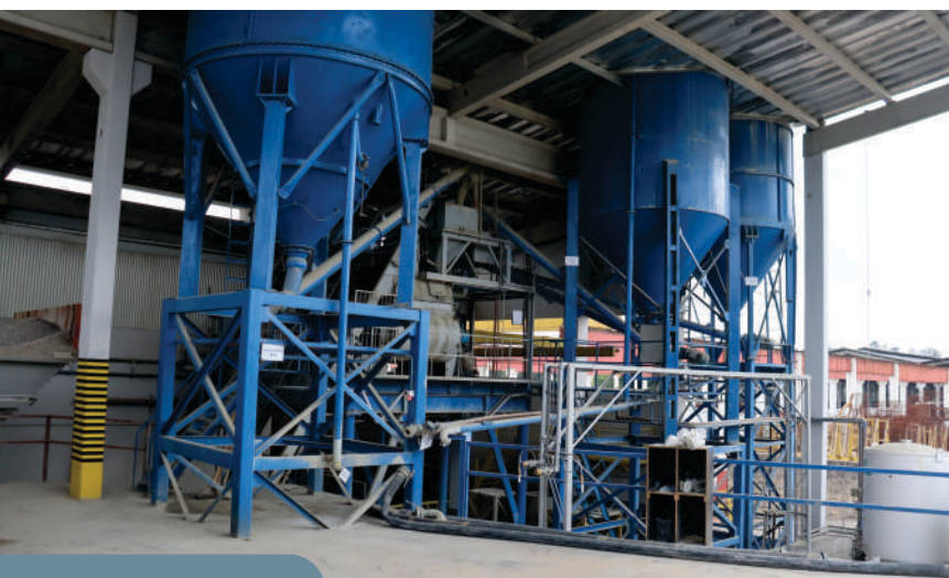
Nova usina em funcionamento na Pré-vale Matriz.
