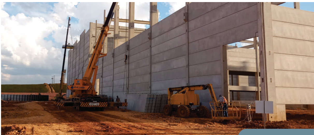
Obra pré-fabricada de concreto, sendo executada em canteiro limpo.
