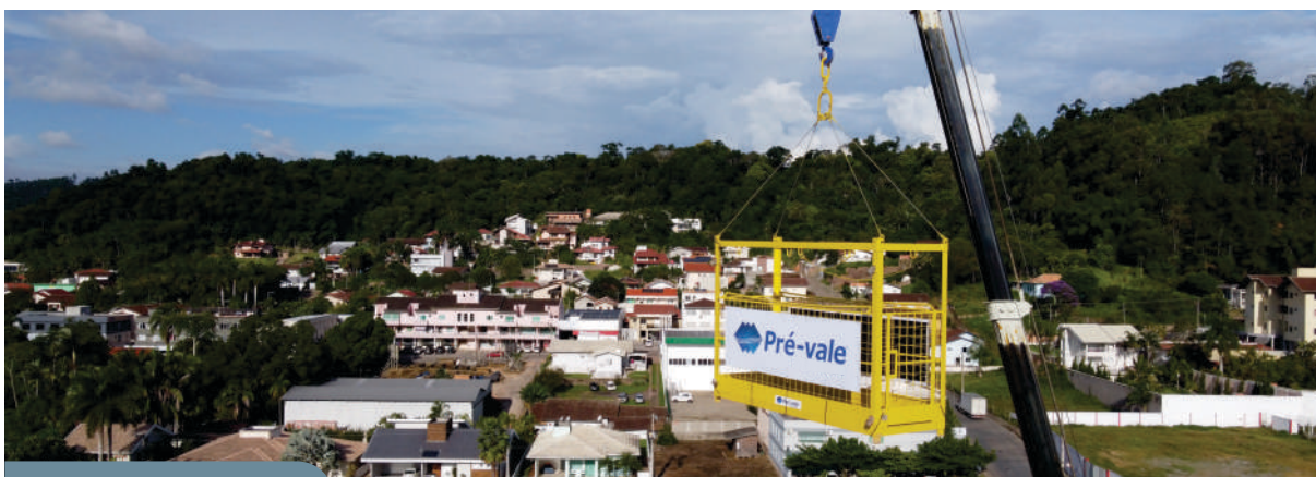
Imagem aérea do cesto no guindaste suspenso, para utilização de rapel.
