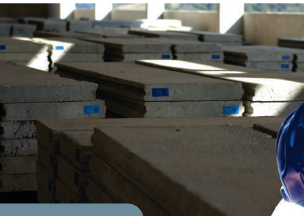
Painéis alocados em obra, aguardando para serem montados.
