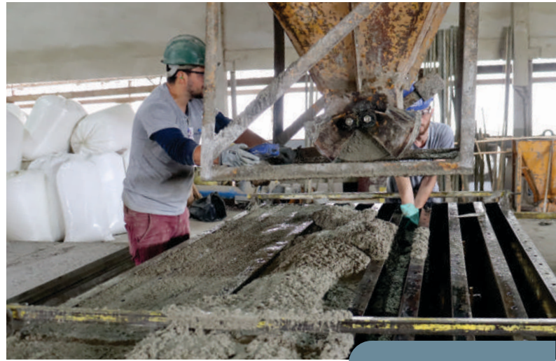
Aplicando o concreto leve nas formas de painéis.
