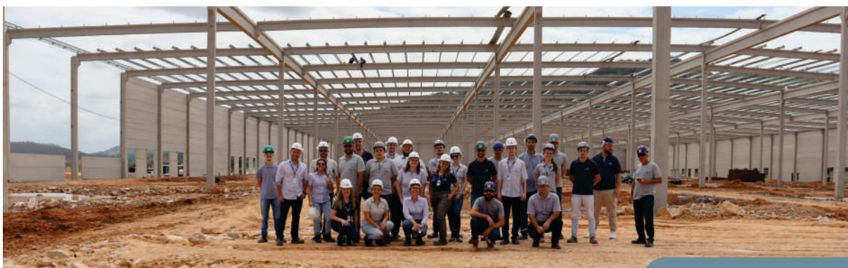
Colaboradores realizando a visita técnica na obra em Itajaí - Lote 011/23.
