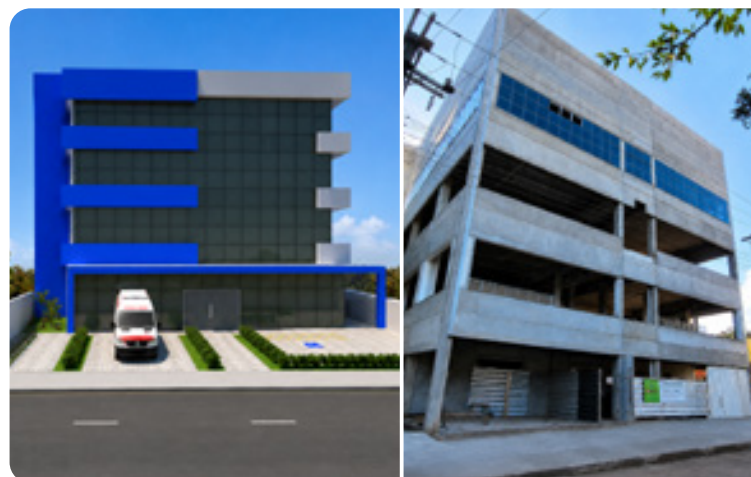
Fotos: projeto | Fachada externa, Fase da obra.
