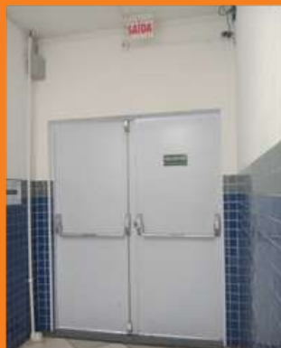
PORTA CORTA FOGO COM BARRA ANTIPÂNICO E CENTRAL DE ALARME DE INCÊNDIO
