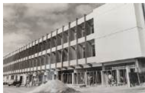
Primeiro prédio da FEARPE
