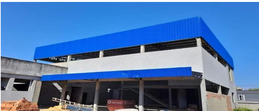
Fase final da obra Capp novo. Ano de 2022. Acervo do CAPP.
